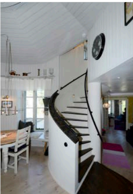
PLATSGJUTET. Husets betongstomme är gjuten på plats. Så även trappan, som är garanterat knarrfri.
