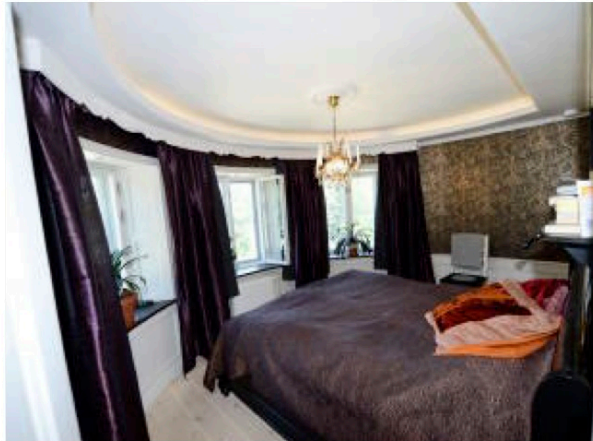
DJUPA NISCHER. I bland annat sovrummet finns specialutvecklade fönster med ett yttre treglasfönster och ett öppningsbart innanfönster. Husets superisolerings skapar djupa fönsternischer så att de kan stå öppna under sommaren.
